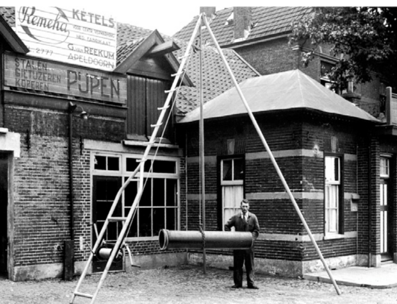
A kondenzációs kazántechnika
